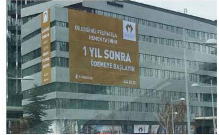
MAHALL Cephe Branda Uygulama
