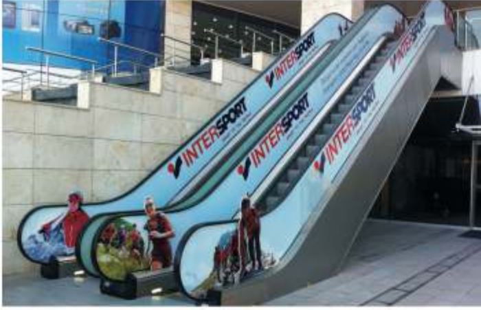
INTERSPORT Dış Mekan Yürüyen Merdiven Uygulama
